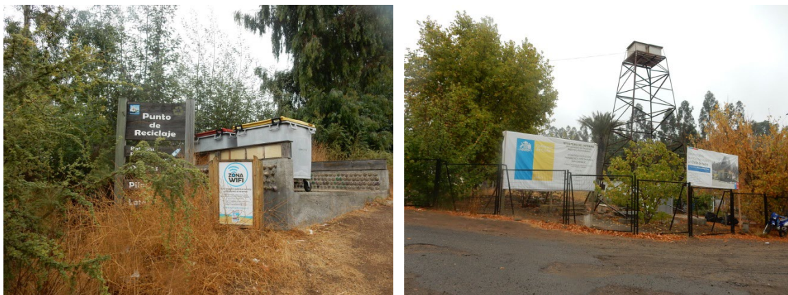
Figura 21 Infraestructura Sanitaria: Punto de Reciclaje y APR
